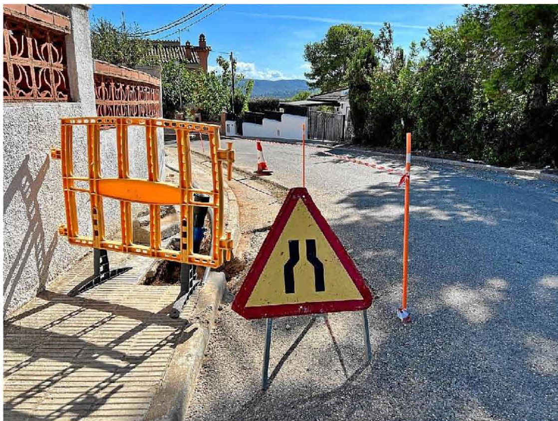
Obres a la xarxa daigua municipal a la Bisbal del Penedès (Foto: Ajuntament de la Bisbal)
